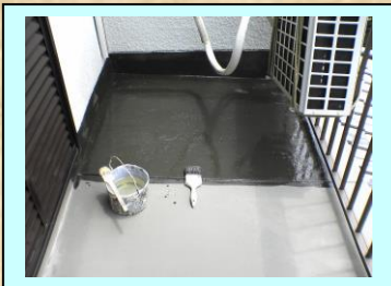
プライマー工事
