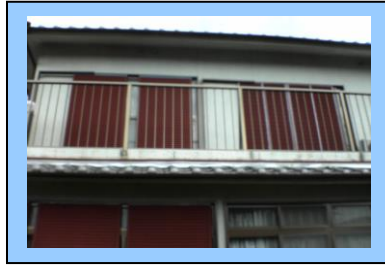
錆止塗装工事
