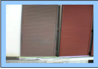
塗装前・錆止塗装
